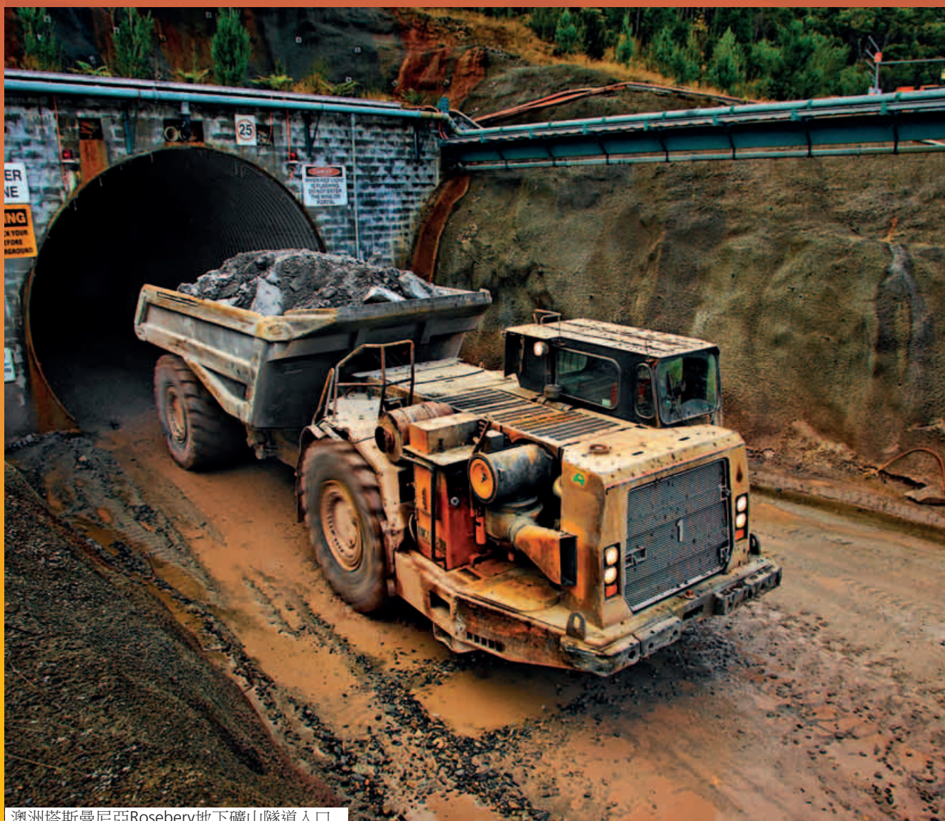
澳洲塔斯曼尼亞Rosebery地下礦山隧道入口
